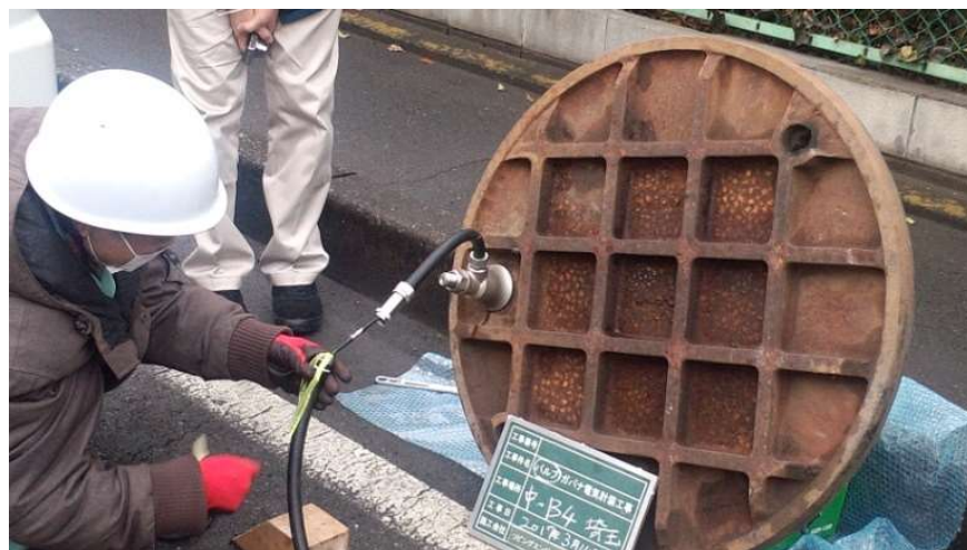
②マンホール蓋へのアンテナケーブル配線
